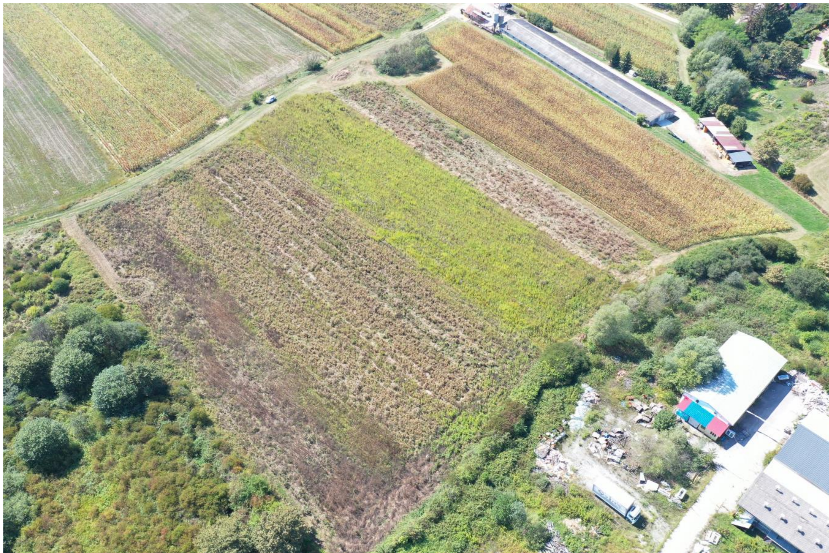
Slika 9. Prikaz postojećeg stanja na lokaciji planiranog zahvata (Izvor: Sunčana elektrana Techno Prosolen 499 kW (TOP2021-21, Solvis d.o.o., Varaždin, svibanj 2021.).
